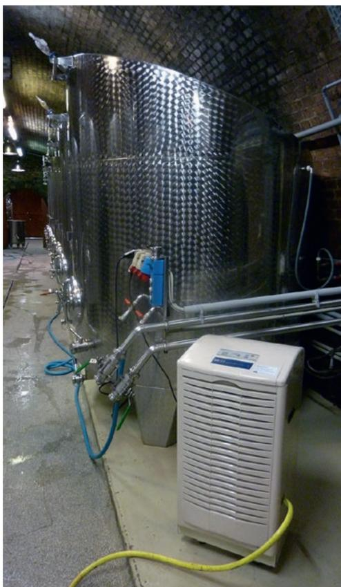
Für Kellerröhren und Tanklager sind Umluft-Kondensationstrockner lieferbar, die mit einem Luftschlauch-System ausgerüstet werden können
