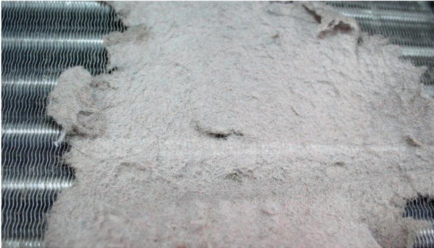
**Lamellenverdampfer mit Staubablagerung:** Um den hohen Hygiene-Ansprüchen gerecht zu werden, müssen bei der Auswahl einige Punkte beachtet werden: Einfach zu reinigende Luftfilter, offene statt geschlossener Wassersammelbehälter (Kontamination durch Schimmel) und einfach zugängliche (optimal selbstreinigende) Kondensator- und Lamellenflächen
